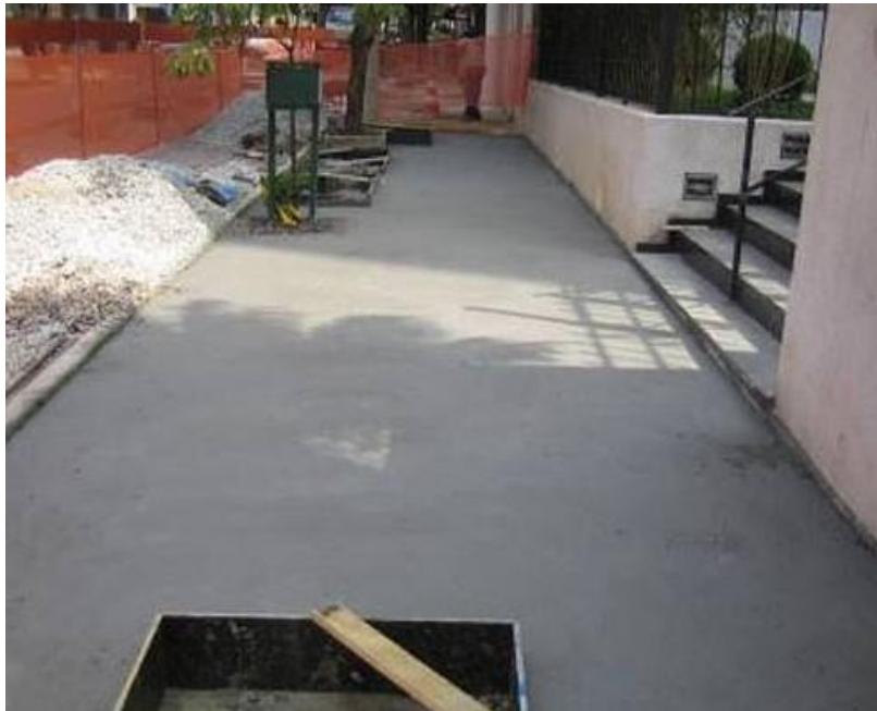
Figura 20: Calçada de Concreto Desempenado Moldado in loco / Fonte: Google
