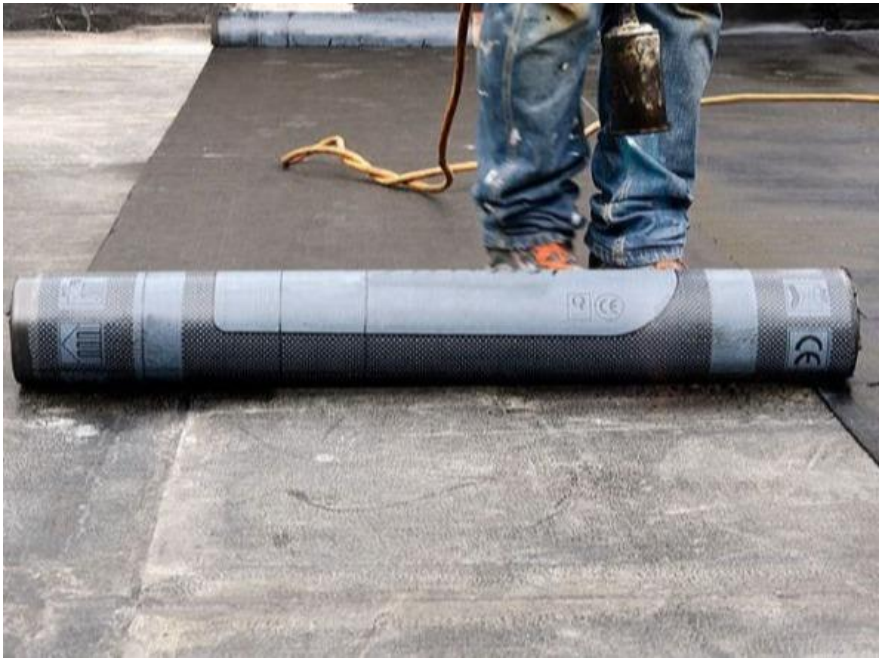
Figura 18: Laje impermeabilizada com manta asfáltica de 4 mm. / Fonte: Google
