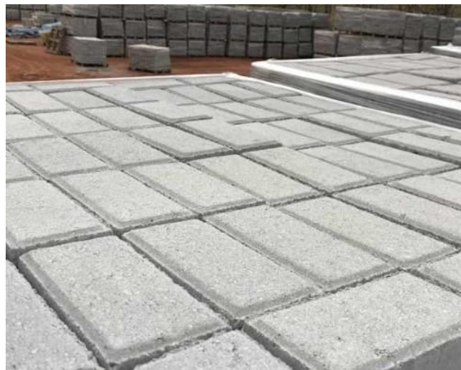
Figura 21: Piso Intertravado Retangular, Cor Cinza Natural, Paginação tipo Fileira / Fonte: Google
