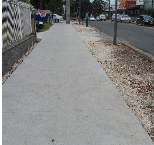
Figura 22: Passeio público em concreto desempenado Moldado in loco / Fonte: Google
